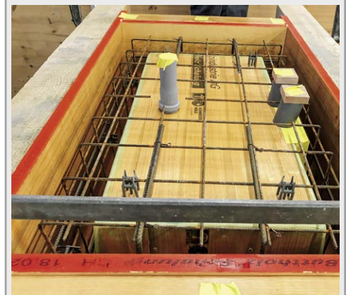
EFZ Schalung und Bewehrung Brunnentrog
