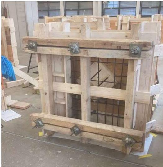
Schalen einiges geändert hat. Unsere Nachfolger stellen die Rückwände mit Elementen wie wir es von der Baustelle kennen, weiter schalen sie zum Teil mit Abschalelementen ab. Sie erstellen auch Bockgerüste, die es ermöglichen auf Raumhöhe schalen und armieren zu können. Uns wurde auch gesagt, dass in nachfolgenden Schalkursen kleinere Objekte sogar betoniert werden und dann auf ihre Genauigkeit überprüft werden. Was aber auffällt, dass die neuen Lehrenden fast alles in
